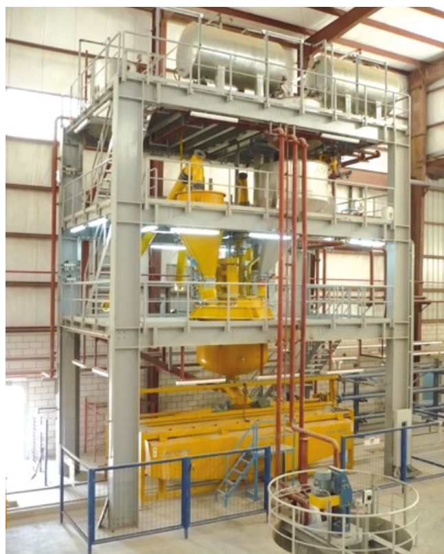
Montage des installations
