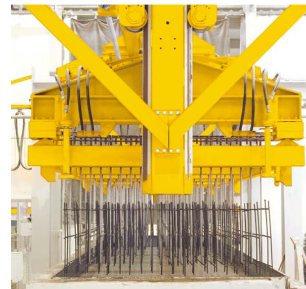
Umieszczenie zbrojenia w formie
